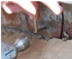
Wenn Sie das Trägerseil mit Schnellankern sichern, müssen Sie mit einem Steinbohrer-Aufsatz ein entsprechendes Loch mit einem Durchmesser von 6,5 mm bohren. Schlagen Sie den Schnellanker anschließend vorsichtig in das Loch und lassen Sie nur das Loch des Schnellankers aus dem Bohrloch schauen. Um sicherzustellen, dass das Loch offen bleibt, können sie vorübergehend einen weiteren Schnellanker in dieses Loch setzen, während Sie die Befestigung an
