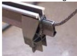
Wenn Sie bereit sind, das Gitter an dem ersten Balken zu befestigen, setzen Sie die Laschen auf der Gitterunterseite auf die Führung auf der Oberseite des Trägerbalkens. Befestigen Sie anschließend das Gitter auf dem ersten Balken, indem Sie lose Balkenklemmen auf der Stern-Anordnung verwenden, die an der Stelle auf dem Balken angeklemt sind. Sie können für eine Erleichterung der Befestigungsarbeit einen Schlitzschraubendreher verwenden. Dies bedeutet, dass der erste Balken enger am zweiten
