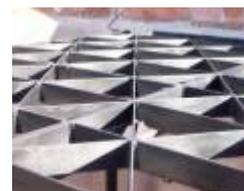
Die Gitter werden mit Hilfe von Balkenklemmen am Balken befestigt. Die Balkenklemmen werden an jeder Ecke des Gitters angebracht. Die Balkenklemmen werden mit den Laschen nach unten angebracht. Die Oberseite der Klemme muss an der Oberseite des Gitters angebracht werden und die Klemme muss anschließend in den Balken geschoben werden.
